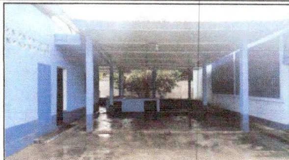
Foto 2: sustitución de lamina por lamina troquelada calibre 26, sustitución de soporte de madera por metal
