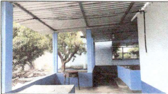
Foto 1: sustitución de lamina por lamina troquelada calibre 26, sustitución de soporte de madera por metal
