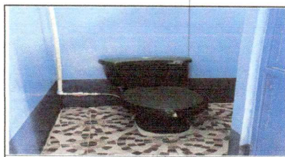
Foto 6: sustitución de sanitarios
